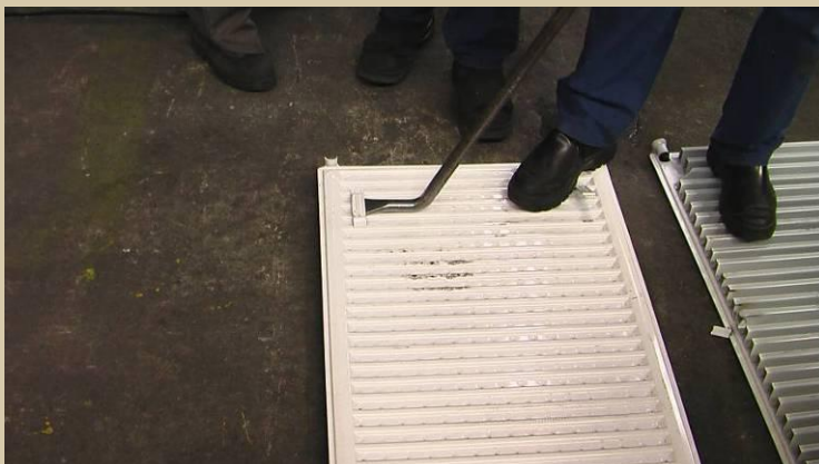
Kontrola privarenia závesných držiakov a pripájacích elementov
